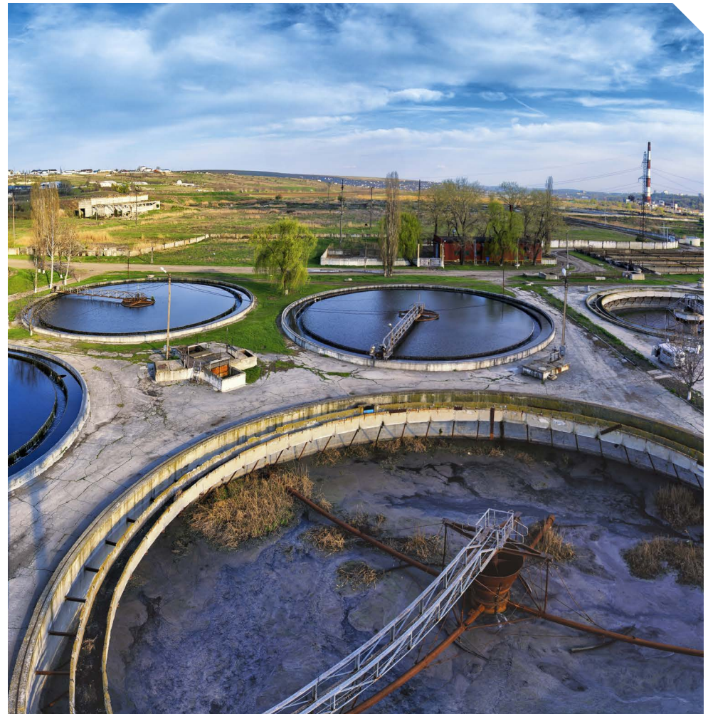
Ook een rioolwaterzuiveringsinstallatie (rwzi) kan een bron zijn van groen gas.
